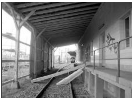
Avril 2002 - Les travaux de mise en place de la protection contre les intempéries et les visiteurs indésirables vont bon train.
